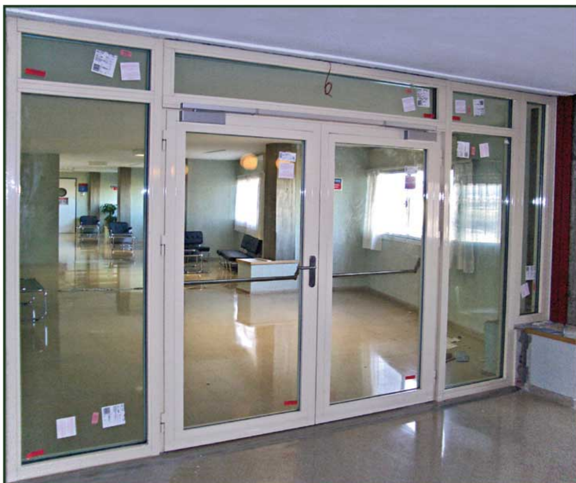
Hospital Mutua de Accidentes de Zaragoza. Puertas y fijos en acero lacado vidriados cortafuegos RF/EI-60
