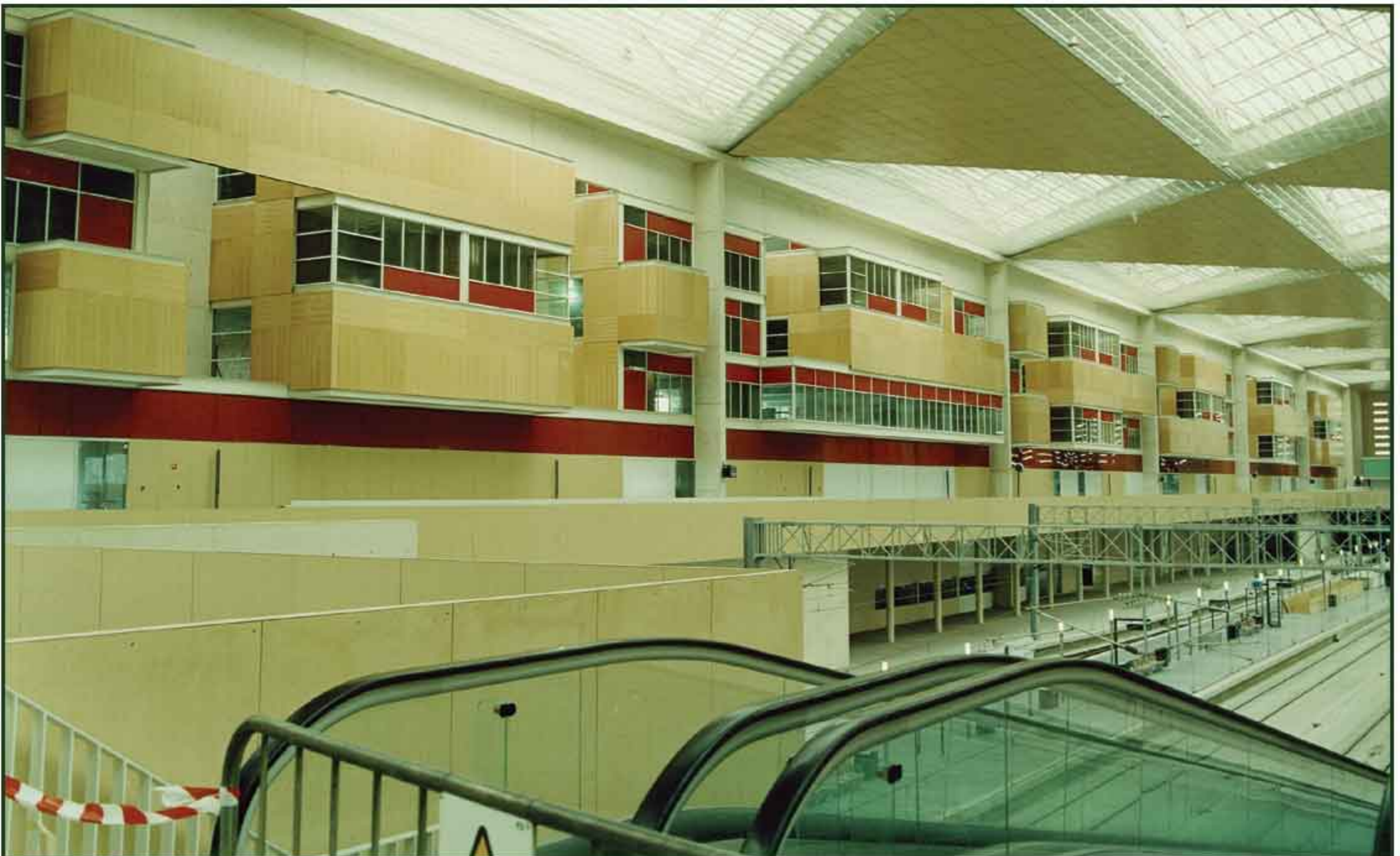
Estación AVE Zaragoza Delicias. Fijos vidriados cortafuegos RF/EI-60
