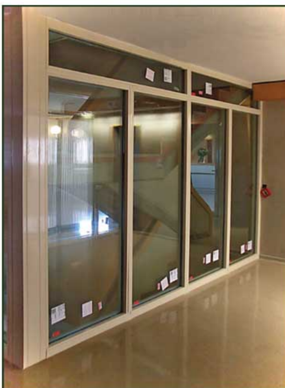
Hospital Mutua de Accidentes de Zaragoza. Puertas y fijos en acero lacado vidriados cortafuegos RF/EI-60
