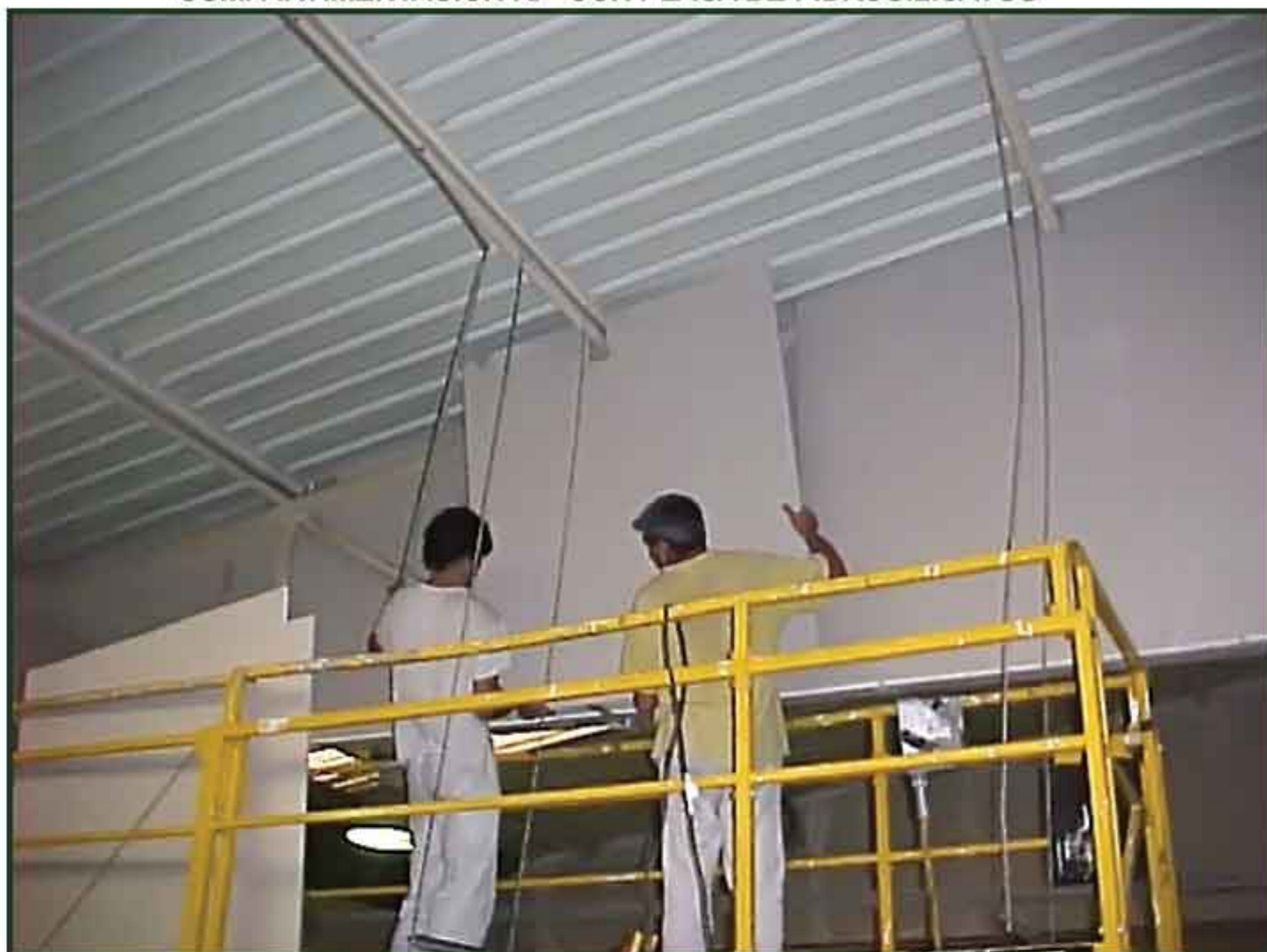
COMPARTIMENTACIÓN RF CON PLACA DE FIBROSILICATOS
