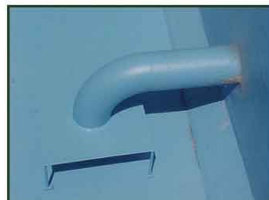
Impermeabilización de depósito de hormigón
